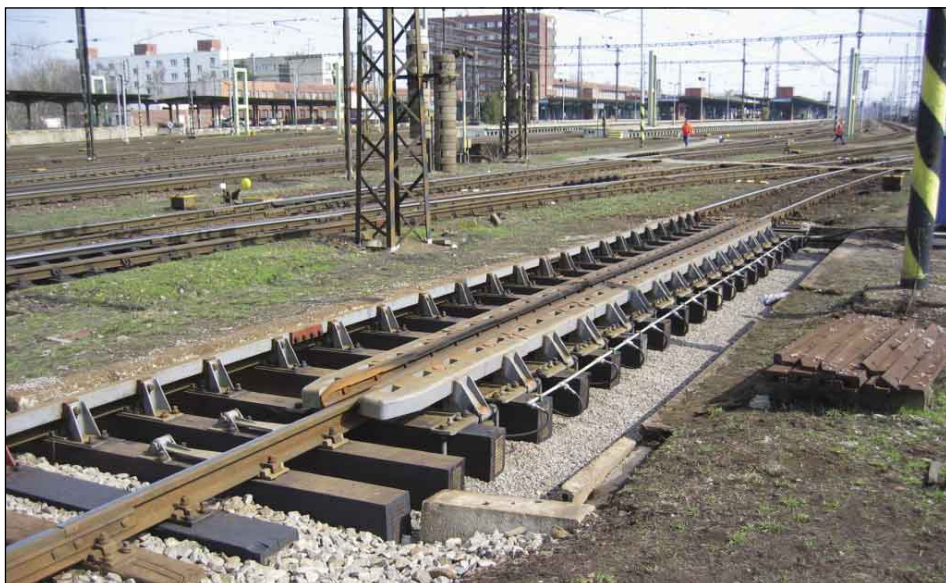
Tíhové závislá kolejová brzda s hydraulickým pohonem na spádovišti v Pardubicích.
